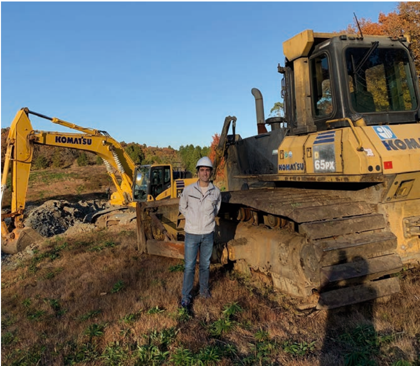
Inicio de los trabajos civiles en Proyecto Solar Fotovoltaico en la prefectura de Ibaraki.
