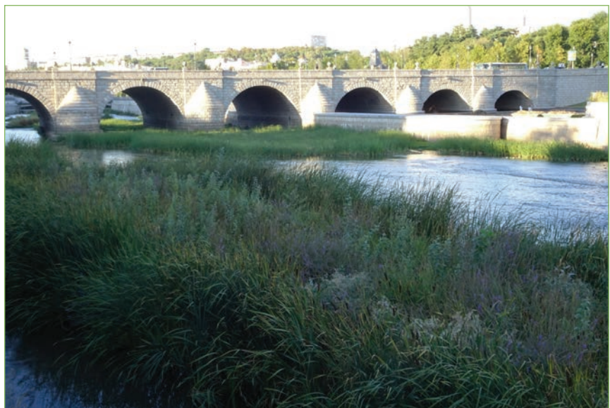
Figura 3. El Manzanares en 2017 aguas abajo del Puente de Segovia.
