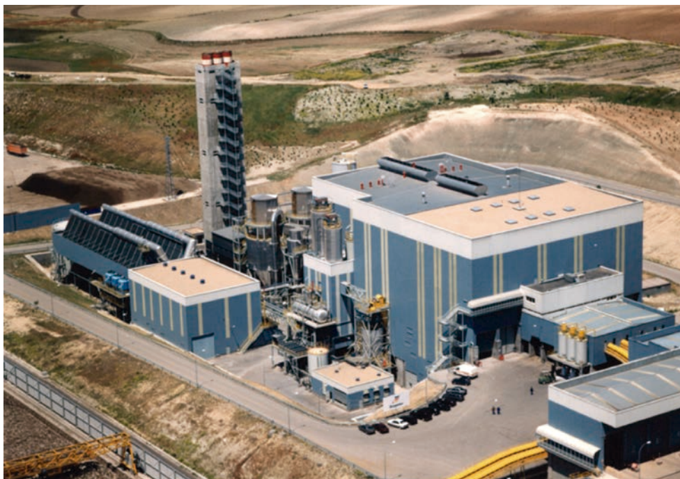
Vista aérea de la planta de valorización energética de Las Lomas.
