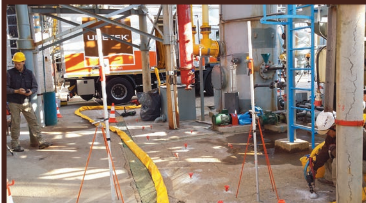
Inyección y monitorización.
