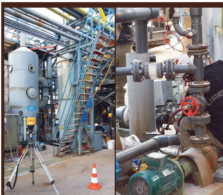
Inyección y monitorización.
